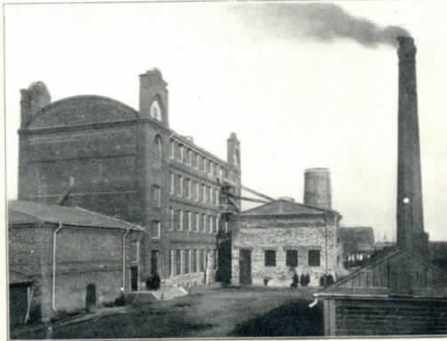
Выполнено для Г. г. Алексея Зарвинова сь Сыновьями в Оренбурге. Около 8300 кв. метр. жел.-бет. перекрытий, силосы, башни, крыши и проч.
