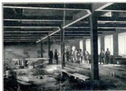
Выполнено для Г. г. Алексей Зарынова съ С-жи (железобетонная конструкция) в Оренбурге.
