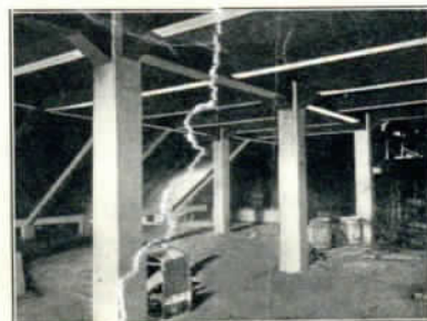
Выполнено для А-го О-ва Хавонинского завода (железобетонная конструкция) в Москве.
