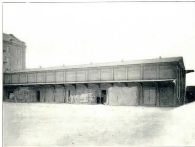
Выполнено для Т-на Пудоловской мельницы в Оренбурге. Железобетонные амбары для склада муки, стены, перекрытия и крыша.
