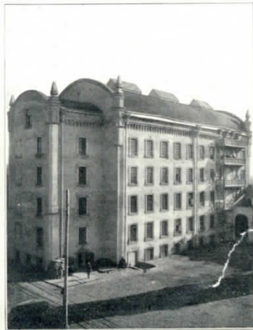
Выполнено для Товарищества Неклютиных мельница в Самаре. Около 11000 кв. метр. жел.-бет. перекрытий, крыши, силосы, гбетницы.
